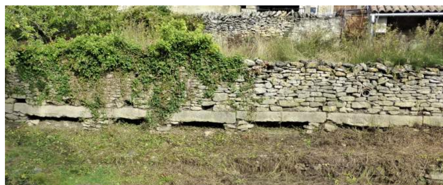
L'aqueduc après son dégagement en 2022
