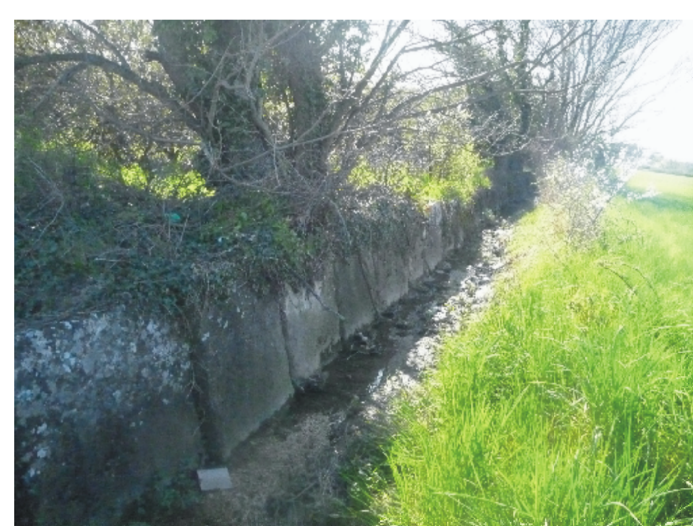
Fossé dallé de la Chalerne, quartier des Sausses
