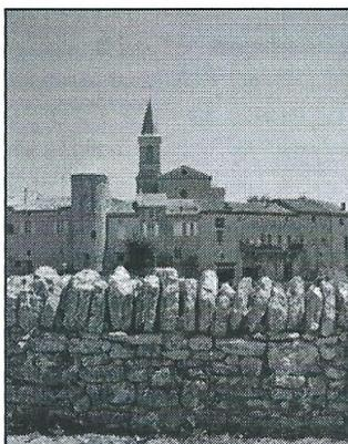
**La maçonnerie à joints vifs,** toutes les pierres sont taillées et reprises pour être ajustées de façon idéale. Il s'agit d'une maçonnerie savante que certains spécialistes ne considèrent pas comme de la pierre sèche tellement sa mise en œuvre demande du temps et du savoir faire. Il s'agit souvent d'une maçonnerie mise en œuvre par les ponts et chaussées au XIXe et début XXe pour soutenir les talus de bords de route.
