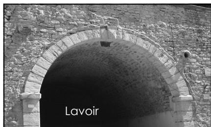
**Claveau** n. m. (dér. De clavis : clef). Archit. Pierre taillée en forme de coin qui entre dans la composition d'un arc ou d'une voûte. Synonyme de voussoir. Le claveau a six faces. En principe, les claveaux d'un arc sont tous concentriques. Les claveaux droits : ils sont taillés en coin et en nombre généralement impair. Celui qui occupe le sommet de l'arc se nomme la clef de voûte. Glossaire des termes techniques, des éditions du Zodiaque
