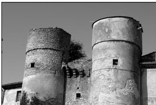
Système utilisé à Taulignan : Mâchicoulis sur corbeaux, (le plus courant) qui, par l'intermédiaire des corbeaux s'appuie sur le rempart massif.
