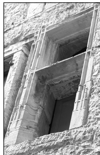
Meneau transversal rue des Fontaines
