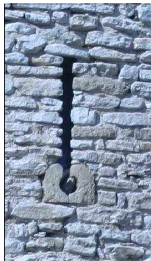
Archère sur la tour ouest.
